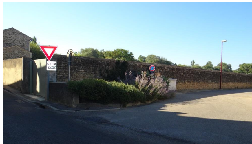
Mur de clôture en pierres rue de la Verrière
