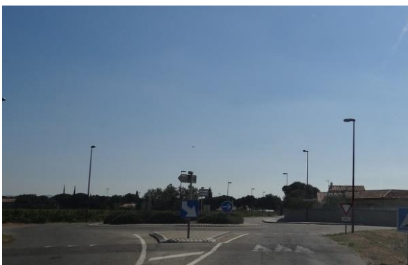
Girotoire Rte du Dauphiné en cours d'aménagement
