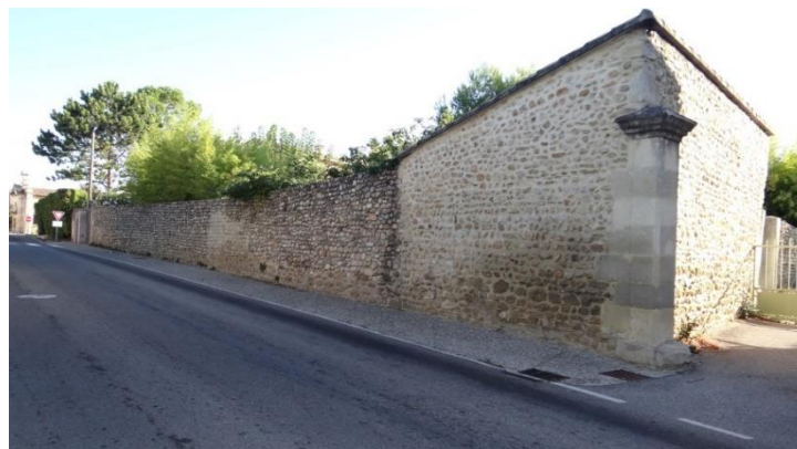
Mur de clôture en pierres rue des Côtes du Rhône
