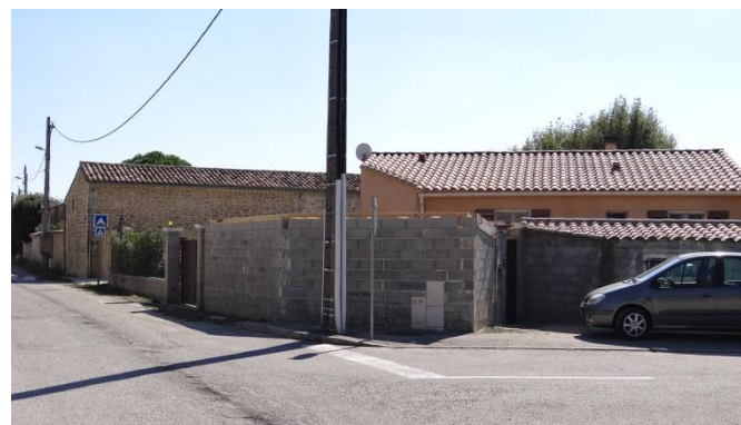
Une finition des murs en parpaing bien souvent repoussée
