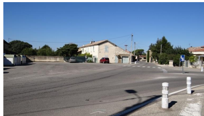
Carrefour RD 141 - Chemin des Aires très vaste et minéral
